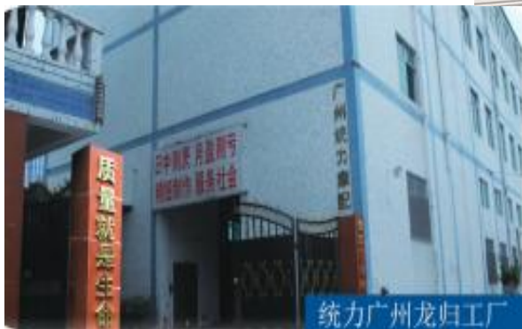
广州统力新能源有限公司 占地10亩，员工85人
